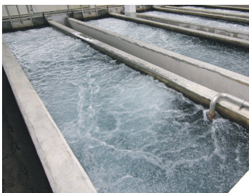
Stația de la Mărtinești: bazine de aerare reabilitate
