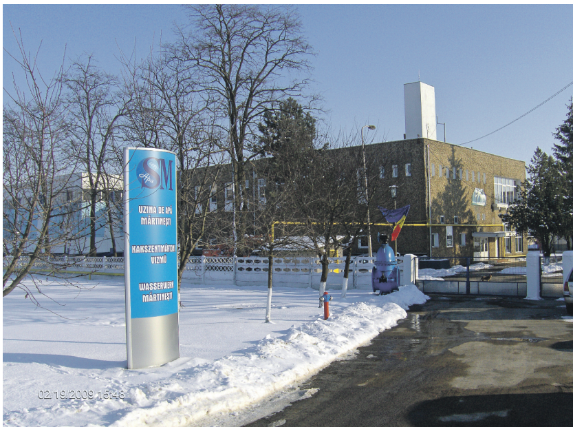
Stația de tratare a apei potabile de la Mărtinești
