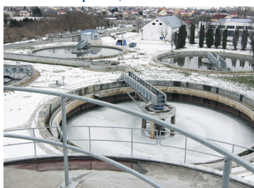
Stația de epurare: decantoare primare reabilitate
