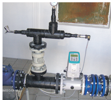
Instalație hidraulică și de control a unui puț de captare a apei reabilitat
